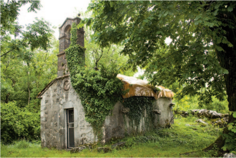
Crkva Sv. Nikole u Očinićima – prije rekonstrukcije
